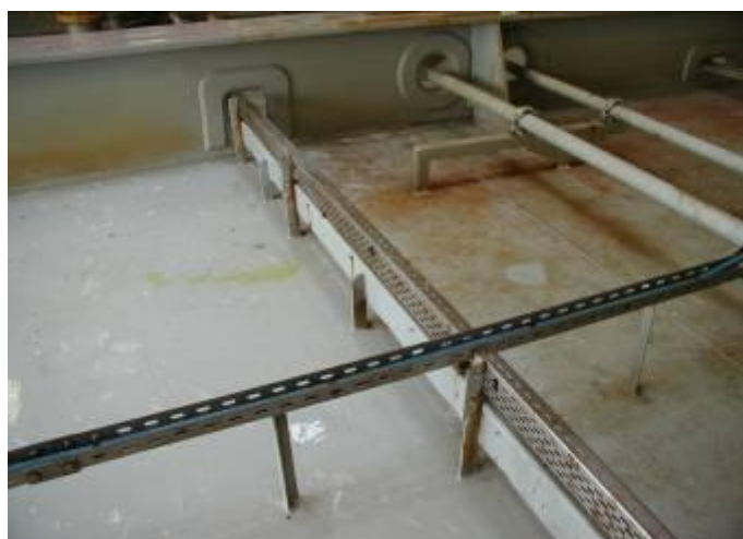
Nettoyage d'une plate-forme pétrolière peinte après un temps de contact de 15 minutes.
